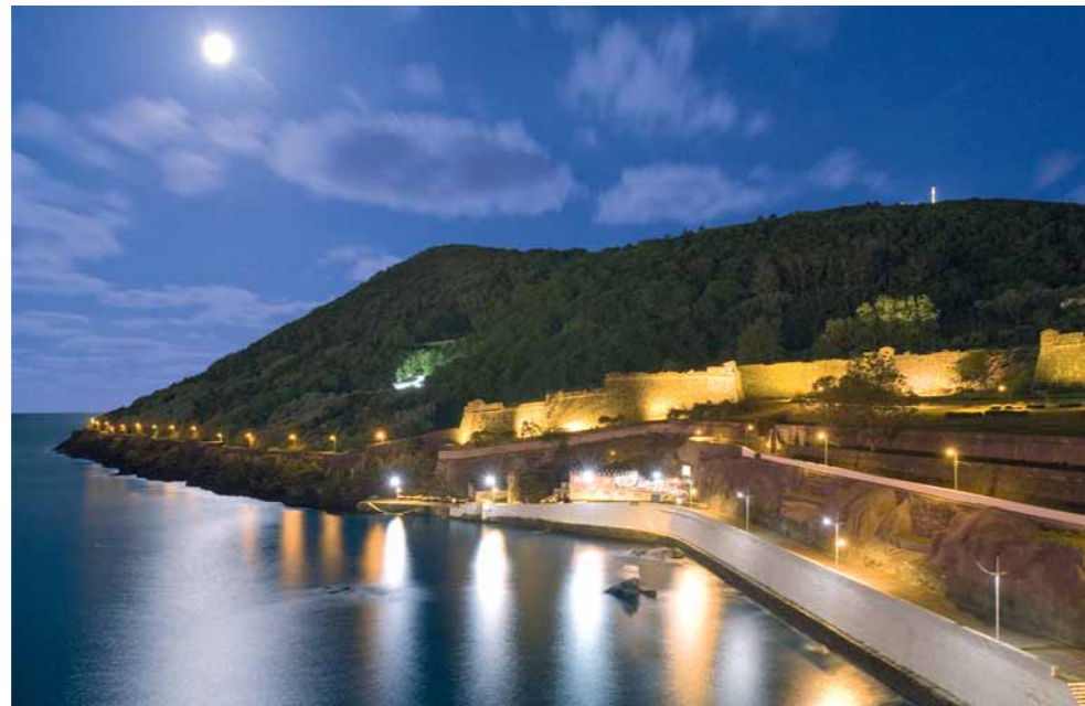
Über vier Kilometer lange Wälle umgeben das Castelo de São João Baptista.
